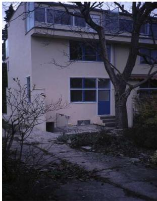
*(Abb. 5) Wien 13, Werkbundsiedlung, Reihenhaus von Gerrit Th. Rietveld, Woinovichgasse, Ansicht des Hauses Nr. 14 von Süden. Neuanstrich von 2000 mit Kunstharz/Kaliwasserglasfarbe. Foto Hammer 2000*
