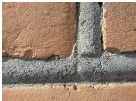
(Abb. 4) Walter Gropius und Adolf Meyer, Fagus-Werk in Alfeld (1911-14), Hauptgebäude, Eingangsbereich, Detail. Die radikale Reinigung mit Sandstrahl (1988) führte zur Beschädigung der Ziegeloberfläche und der (ursprünglichen?) Verfugung.
