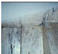
*(Abb. 9) Brunn, Haus Tugendhat, Ludwig Mies van der Rohe (1928-30), Eingangstreppe, Detail. Handwerkliche Kittungen des Travertins mit farblich und technisch nicht kompatibelem Material. Foto Hammer 1992.*
