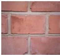
*(Abb. 2) Ludwig Mies van der Rohe; Haus Lemke, Berlin-Hohenschönhausen (1932/33), Detail der mit Sandstrahl radikal gereinigten Fassade mit erneuerter Verfugung. Foto Hammer 2001*
