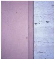
(Abb. 3) Ludwig Mies van der Rohe, Haus Urbig, Potsdam-Neubabelsberg (1924-26), Detail der Fassade. Der rote Fassadenputz ist vollständig erneuert. Foto Hammer 2001
