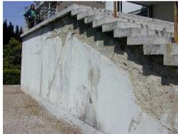
*(Abb. 7) Brunn, Haus Tugendhat, Ludwig Mies van der Rohe (1928-30), Außentreppe. Die Stufen aus Travertin wurden bei der Renovierung 1981-85 wahrscheinlich vollständig erneuert. Aktuelle Schäden durch statische Probleme und einen filmbildenden Anstrich auf dem Verputz. Foto Hammer 2003*
