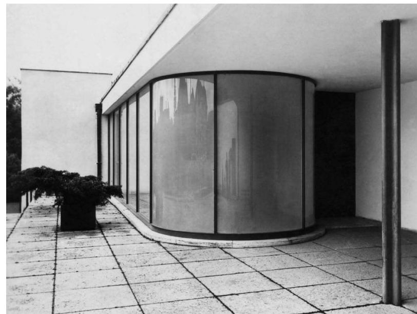
Vila Tugendhat, uliční průčelí – detail vstupu, po 1931, foto Rudolf de Sandalo
