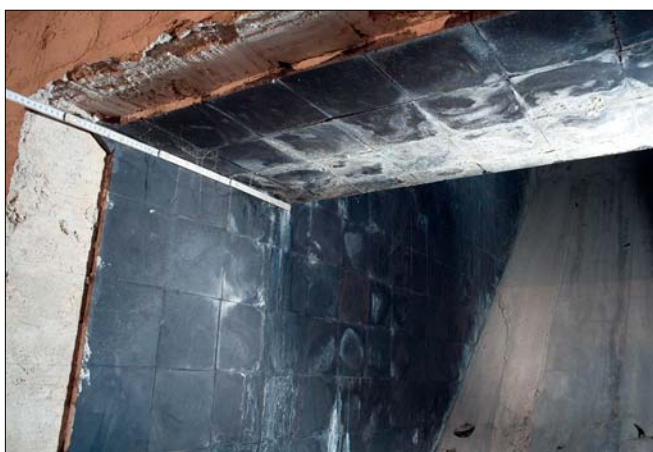
Obr. 1: Vila Tugendhat: a – původní světlá keramická dlažba zn. RAKO CZECHOSLOVAKIA, dochovaná pod příčkou z 80. let v kuchyni v hlavním obytném podlaží (2. NP); b – původní černá keramická dlažba, zřejmě také zn. RAKO CZECHOSLOVAKIA dochovaná v obložení shozu na koks v někdejší skladu koksu v technickém podlaží (1. NP) (všechny snímky D. Židlický, 2010, není-li uvedeno jinak).
