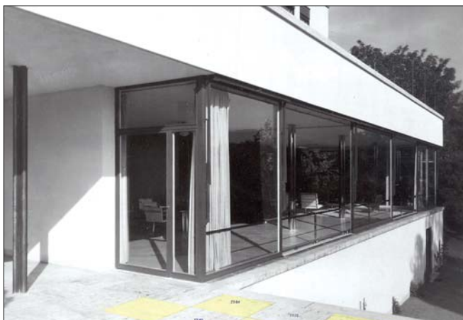
Obr. 7: Vila Tugendhat, zahradní terasa (počátek 30. let 20. stol.) s vyznačením původní šachovnicové orientace travertinových desek (MuMB, Fond Oddělení dějin architektury a urbanismu – vila Tugendhat, kopie v SDC-VT, zakres I. Wahla).
