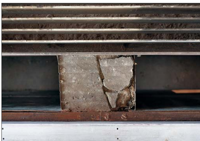
Obr. 12: Vila Tugendhat: a – podlahová vyústka vzduchotechniky u zimní zahrady z vyjmutou žaluzií; b – betonový vymezení kvádr s ocelovým pláštěm a s původní izolací z vlnitého papíru zajišťujícího protihlukovou ochranu (foto M. Žáček, 2010).
