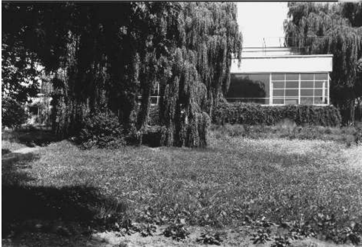
Abb. 93: Haus Tugendhat, Blick von Süden, 1963: In der noch erhaltenen Scheibe spiegelt sich die Trauerweide.
