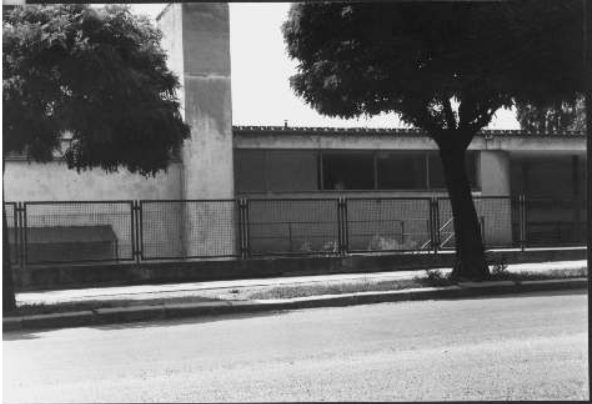
Abb. 94: Haus Tugendhat, Blick von Norden, 1963: Der Rauchfang ist erhöht, der Kdurchblick zwischen Garage und Schlafzimmern und das Treppenhaus sind vermauert.
