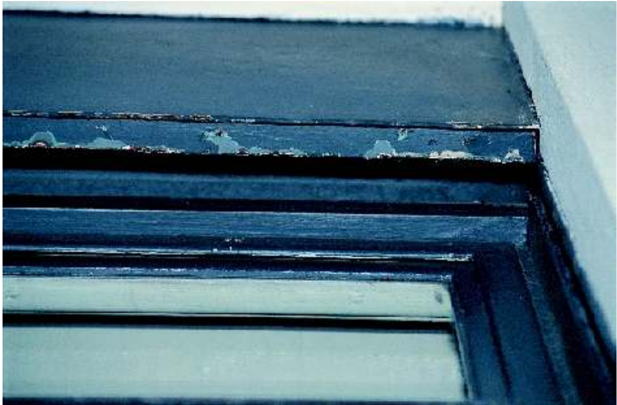
Farbabb. 17: Haus Tugendhat, Kfenster des Zimmers der Tochter Hanna, Detail. In beschädigten Bereichen sieht man auf der roten Grundierung folgende Farbschichten: Weiß, dunkles Blaugrau, helleres Blaugrau, Blaugrün, rezentes dunkleres Blaugrau.
