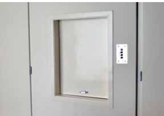
Znovu byl zprovozněn i jídelní výtah
