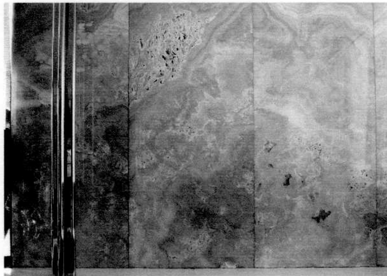
Interior de la casa Tugendhat, salón grande. Pilar cromado y pared de ónix: las únicas superficies originales visibles. Foto: Ivo Hammer, 2005.
